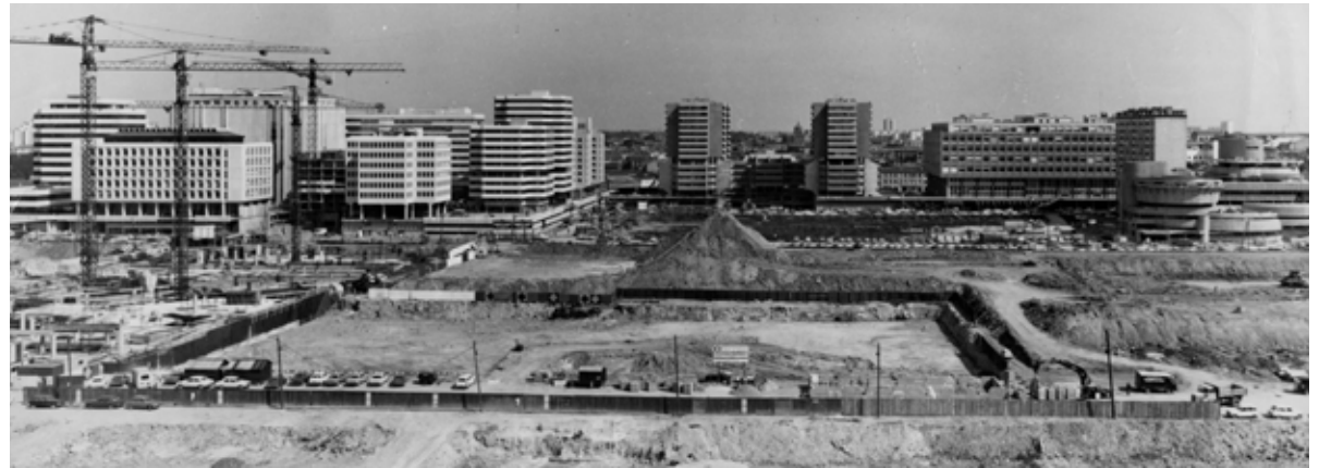
Une «grappe de tours» : Le chantier de Mériadeck - 1976 - Sources : A'Urba ©
