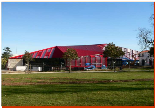
Construction du pôle culturel à Palmer
