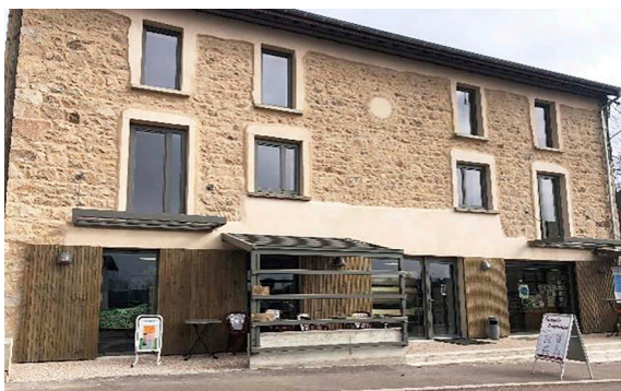
Nota : photo prise en mars 2023. Travaux en cours (garde-corps).
