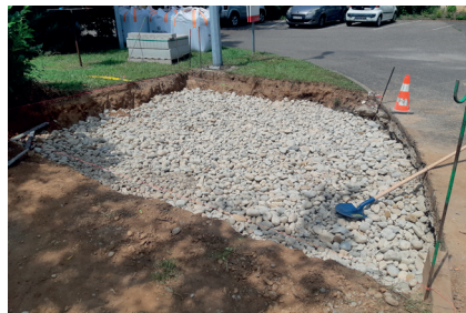
Mise en place de galets, © Grand Lyon
