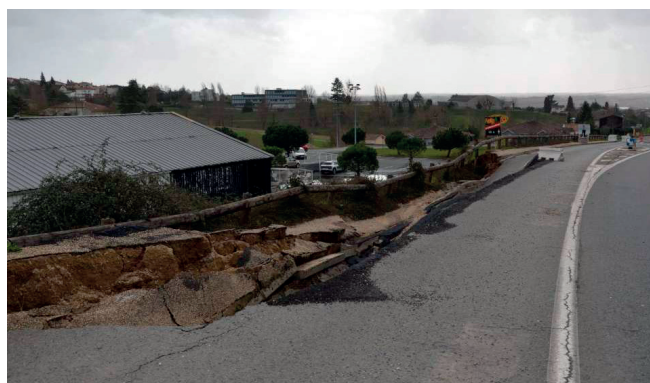
Effondrement de la RD 670 à La Réole suite aux intempéries, © Elise Artigue Cazcarra
