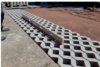
Pose du revêtement final, © Grand Lyon
