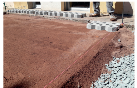
Pose d'une surcouche de sable, © Grand Lyon
