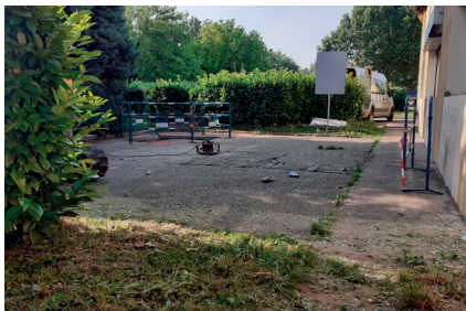
Préparation du chantier, © Grand Lyon
