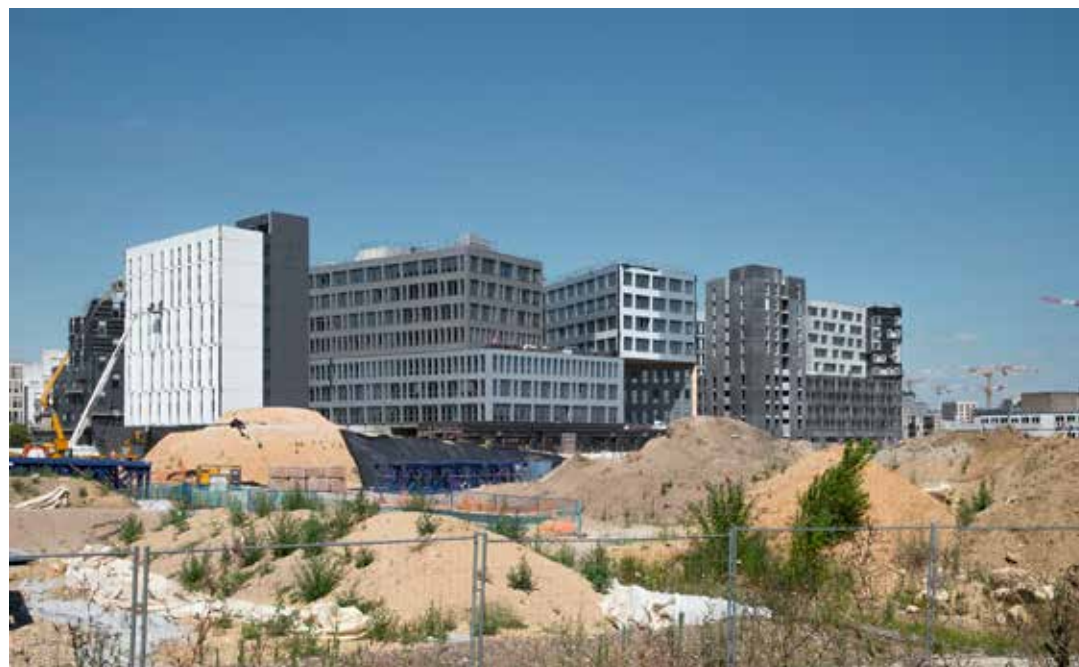
source : chantiers à Euratlantique, Hélène Dumora, a'urba, 2018
