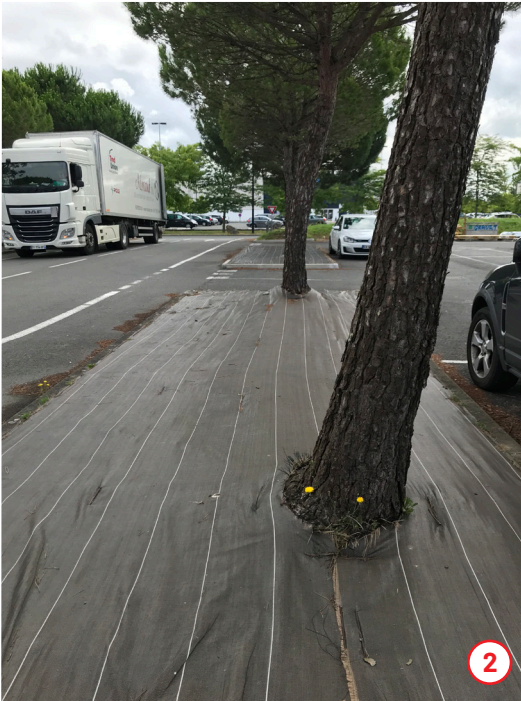
Terre-pleins bâchés avec géotextile noir
