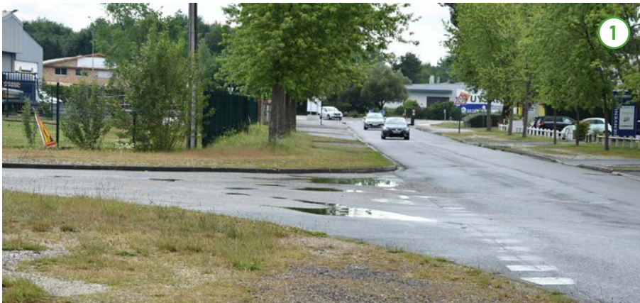
Trottoir en stabilisé et pleine terre
