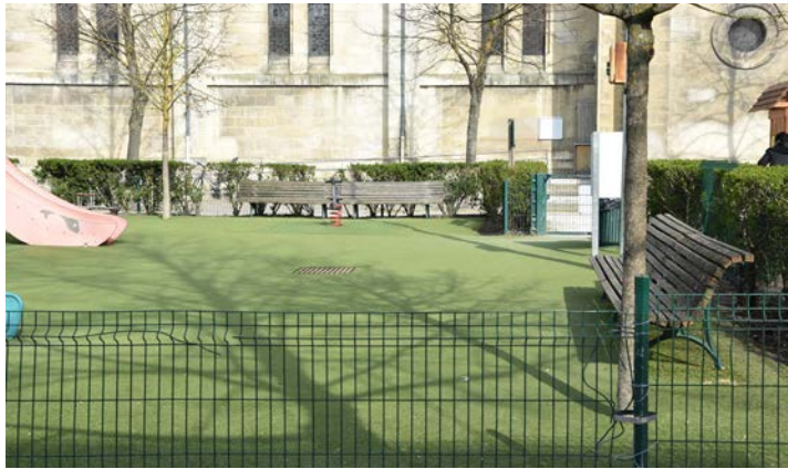
Soupirail condamné ne permettant pas le rafraîchissement de la rue
