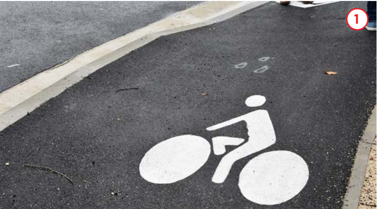
Absence de trottoirs
