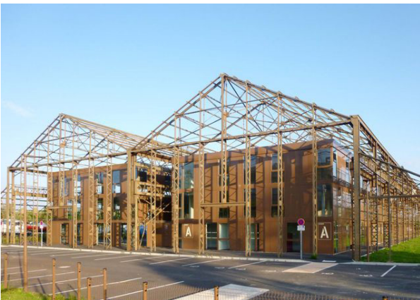
Réhabilitation des ateliers Louis Blériot en bureaux, Bernard Bühler Architecte, Bègles © Agence Bühler
