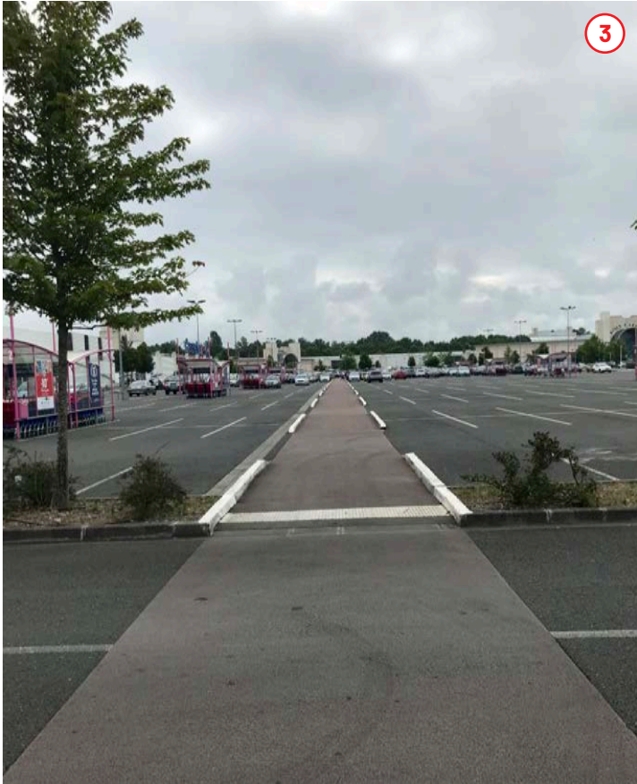
Absence d'ombrage sur les cheminements piétons...
