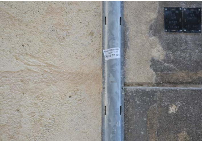
Ravalement des façades
