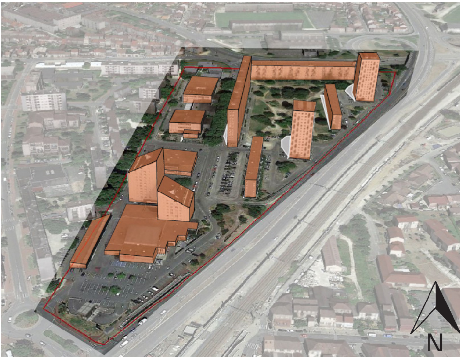
Vue aérienne prise le midi : peu d'ombre apportée par le bâti et forte chaleur - Source Google Earth (31 juillet 2013)
