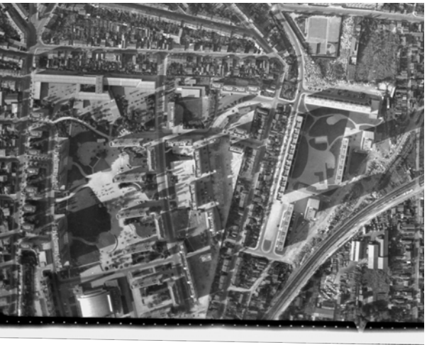
1962 - La Cité de la Benauge avant réaménagement de la rue du Recteur Thamin
