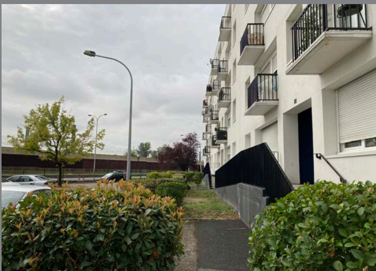
3 Façades claires Végétation herbacée, arbustive et arborée en pied d'immeuble
