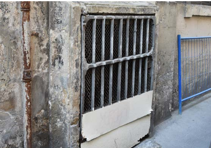
Perméabilité des bouches d'aération des caves
